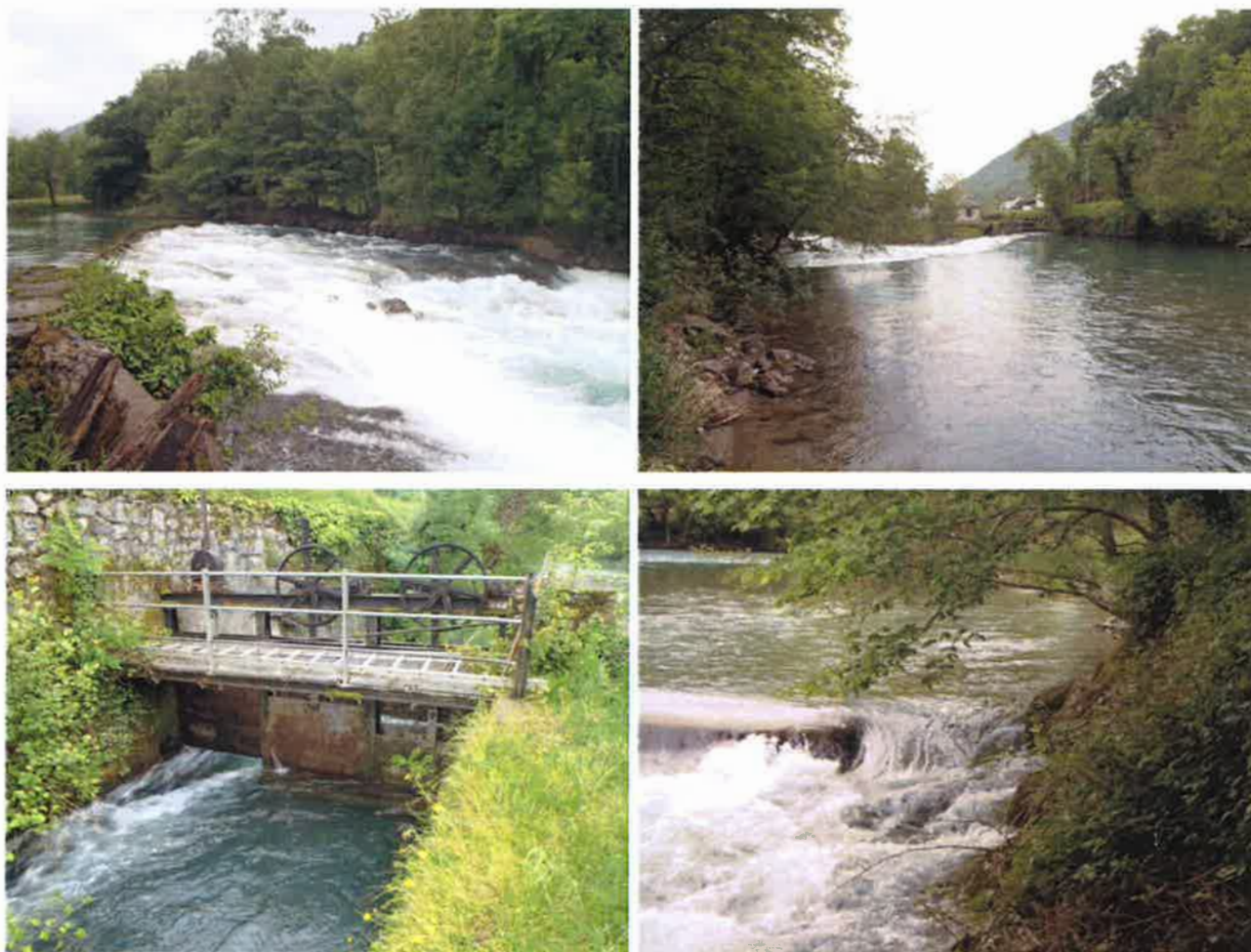
Figure 2 : Photos du seuil et de la prise d'eau
